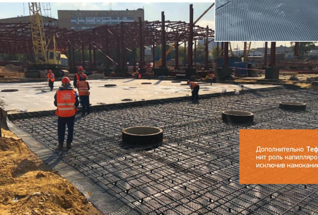
Дополнительно **Тэфонд НР СТАР** выполнит роль капиллярно-прерывающего слоя, исключив намокание плиты пола.
