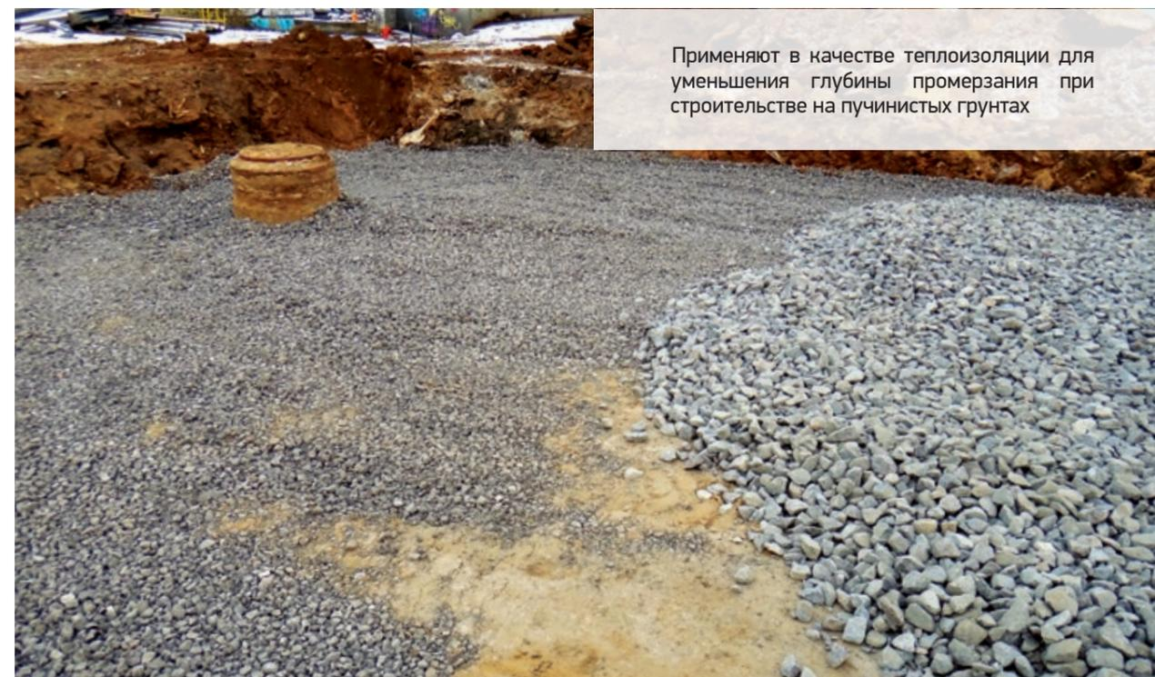
Применяют в качестве теплоизоляции для уменьшения глубины промерзания при строительстве на пучинистых грунтах
