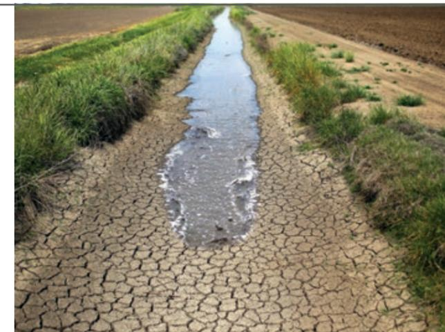
В процессе эксплуатации каналы заиливаются, зарастают сорной растительностью, откосы размываются водой, дамбы деформируются. Это снижает пропускную способность каналов, увеличивает фильтрацию воды в грунт, снижает КПД оросительных систем.
