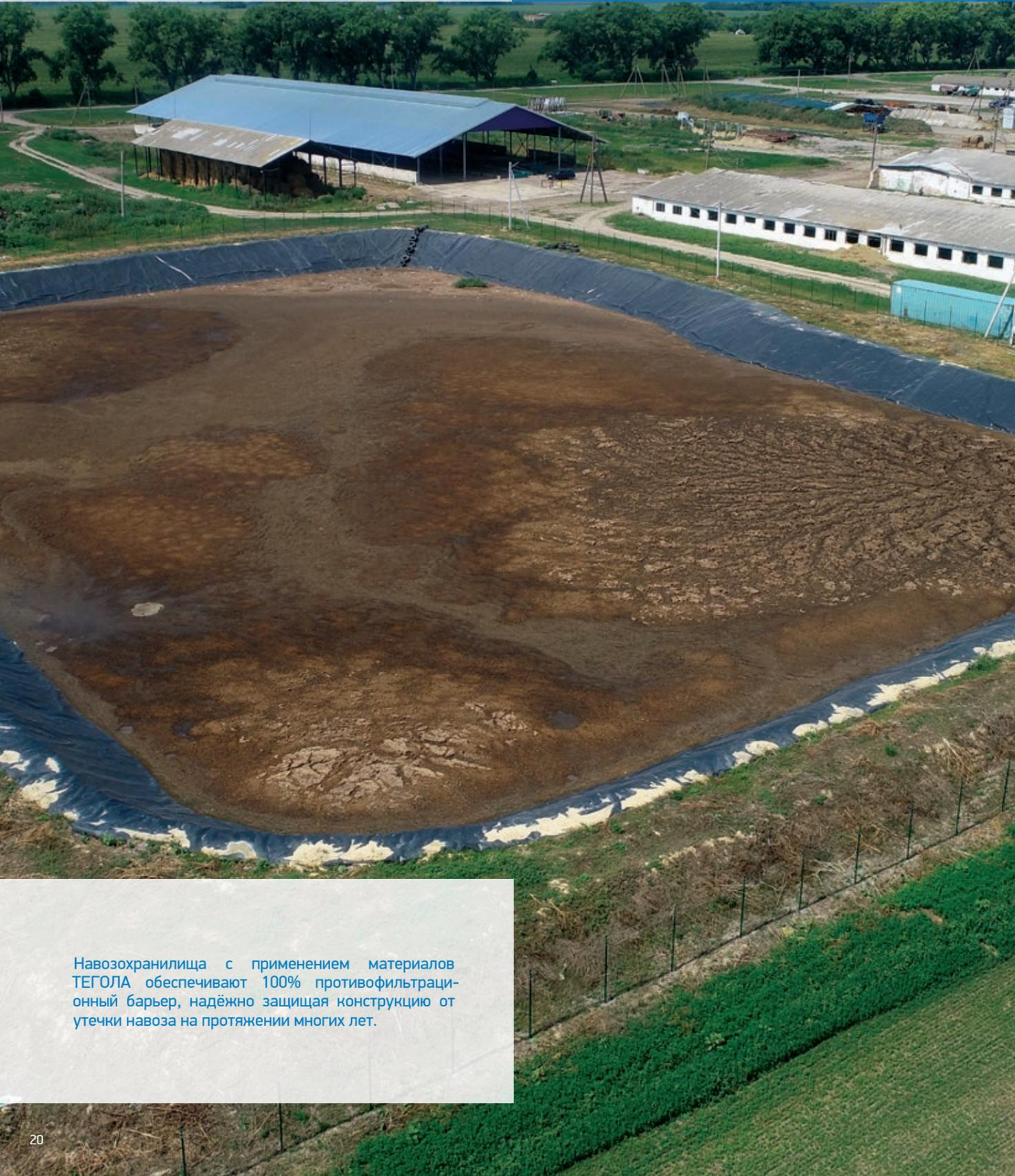
Навозохранилища с применением материалов ТЕГОЛА обеспечивают 100% противofильтрационный барьер, надёжно защищая конструкцию от утечки навоза на протяжении многих лет.
