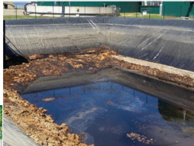
Конструкция открытой лагуны — это выкопанный грунтовый котлован, на рабочей поверхности которого укладывается слой защитного нетканого полотна, поверх которого монтируется гидроизоляционная мембрана Cover Up XLT Black.
