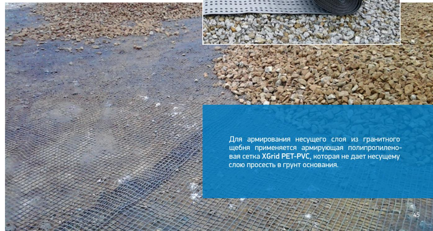
Для армирования несущего слоя из гранитного щебня применяется армирующая полипропиленовая сетка **XGrid PET-PVC**, которая не дает несущему слою просесть в грунт основания.
