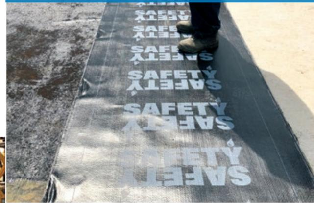
Профилированная мембрана **Тефонд НР СТАР** обеспечит надежную защиту гидроизоляционного слоя во время устройства несущей плиты пола.
