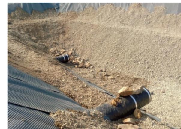
Необходимо проклеить герметизирующей лентой места окончания дополнительного изоляционного ковра и установить хомуты в местах проклейки.
