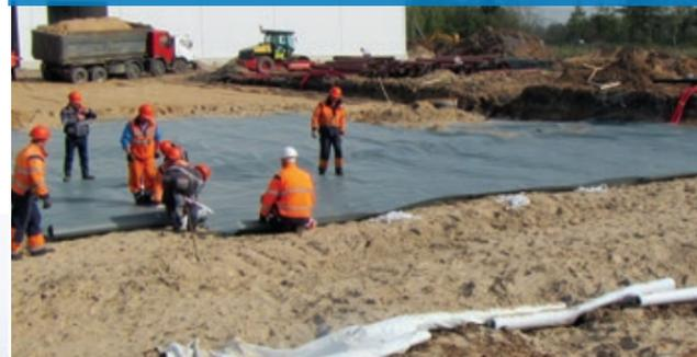
Применение дренажного геокомпозита **QDrain ZW** позволяет уйти от трудоемкого и дорогостоящего процесса устройства щебеночной отсыпки. По дренажной эффективности **QDrain ZW** превосходит слой гранитного щебня толщиной 500 мм более чем в 4 раза.
