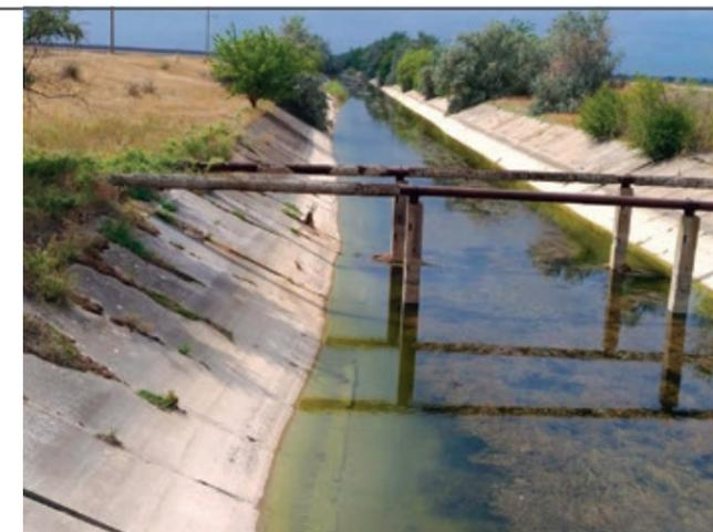
Фильтрация воды в грунт способствует заболачиванию прилегающих к каналам земель, повышению уровня грунтовых вод на орошаемых полях с последующим процессом засоления за счет подтягивания солей к верхней части почв, что приводит к снижению плодородия почв орошаемых земель.
