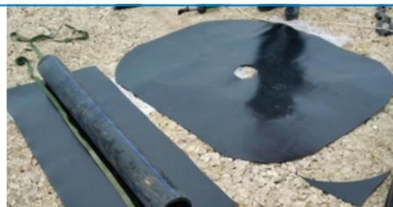
**3** Осуществление сварных работ в местах примыкания дополнительного изоляционного ковра к пластиковой трубе и основному слою гидроизоляционной мембраны COVER UP при помощи горячего воздуха.
