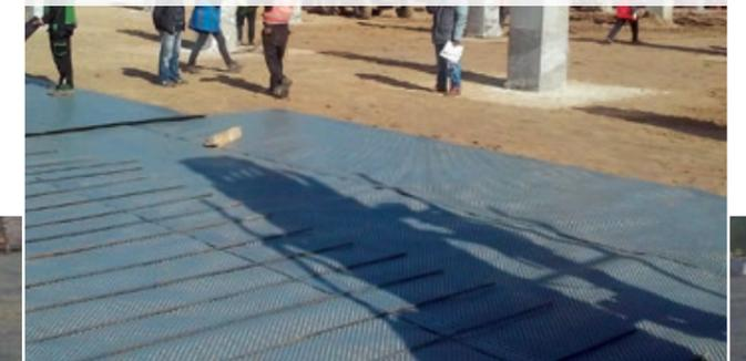
Экструзионный пенополистирол предотвратит перенос тепла между областями охлаждения и обогрева, сохраняя энергетическую эффективность конструкции.
