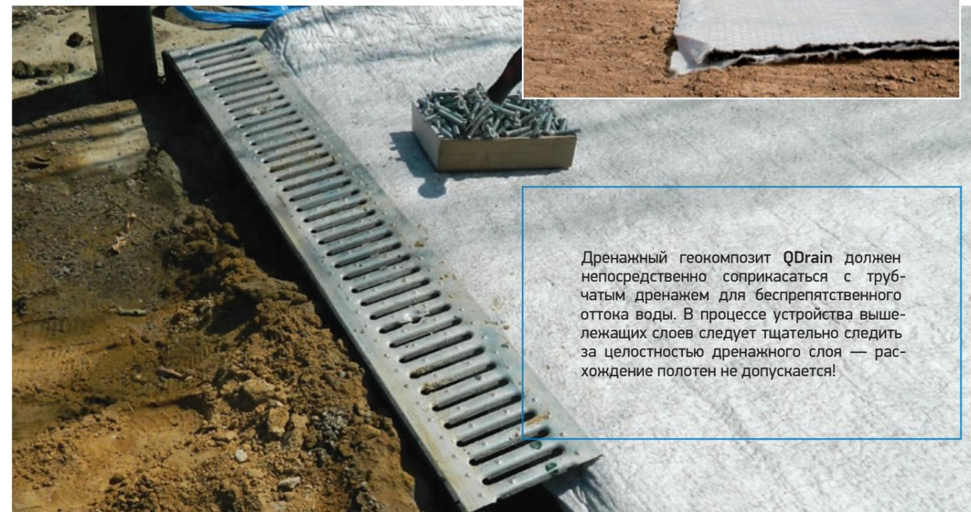
Дренажный геокомпозит QDrain должен непосредственно соприкасаться с трубчатым дренажем для беспрепятственного оттока воды. В процессе устройства вышележащих слоев следует тщательно следить за целостностью дренажного слоя — расхождение полотен не допускается!
