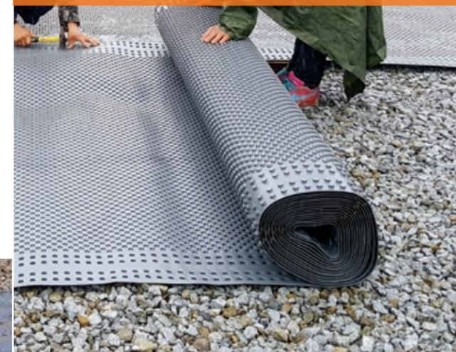
Профилированная мембрана **Тэфонд НР СТАР** предотвращает утечку цементного молочка в слой щебня.
