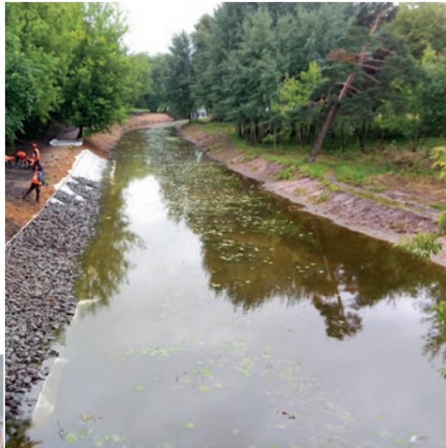
Хаотичная структура волокон геомата способствует ограничению перемещения каменных зерен, предотвращая размыв защитного слоя. Водонепроницаемая подложка не допускает инфильтрацию воды в грунт основания.
