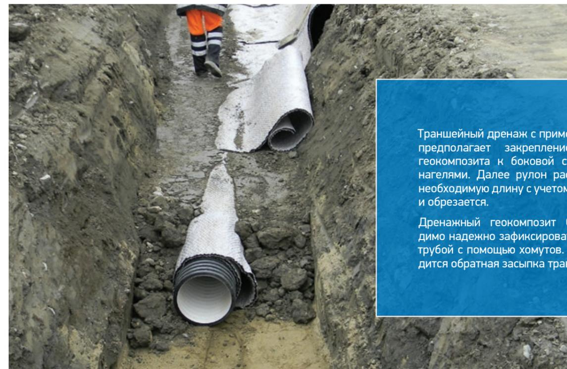
Траншейный дренаж с применением QDrain предполагает закрепление дренажного геокompозита к боковой стенке траншеи нагелями. Далее рулон раскатывается на необходимую длину с учетом оборота трубы и обрезается.
