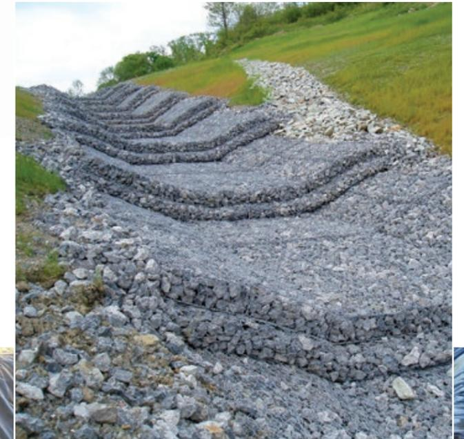
Для обеспечения эффективного организованного отвода воды в условиях высоких скоростей течения воды дно и стенки канавы укрепляются мембраной **COVER UP** совместно с матрачно-тюфячными габионами.
