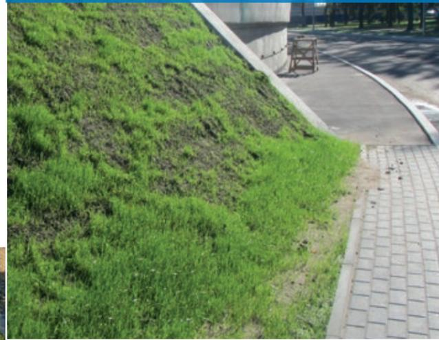
Хаотичная структура волокон ограничивает перемещения частиц грунта поверх геокомпозита, обеспечивая противоэрозионную защиту, а биоразлагаемая льняная подложка служит естественным фильтром, не допуская вымывание семян и помогает сохранять влагу, исключая жесткие требования по поливу.
