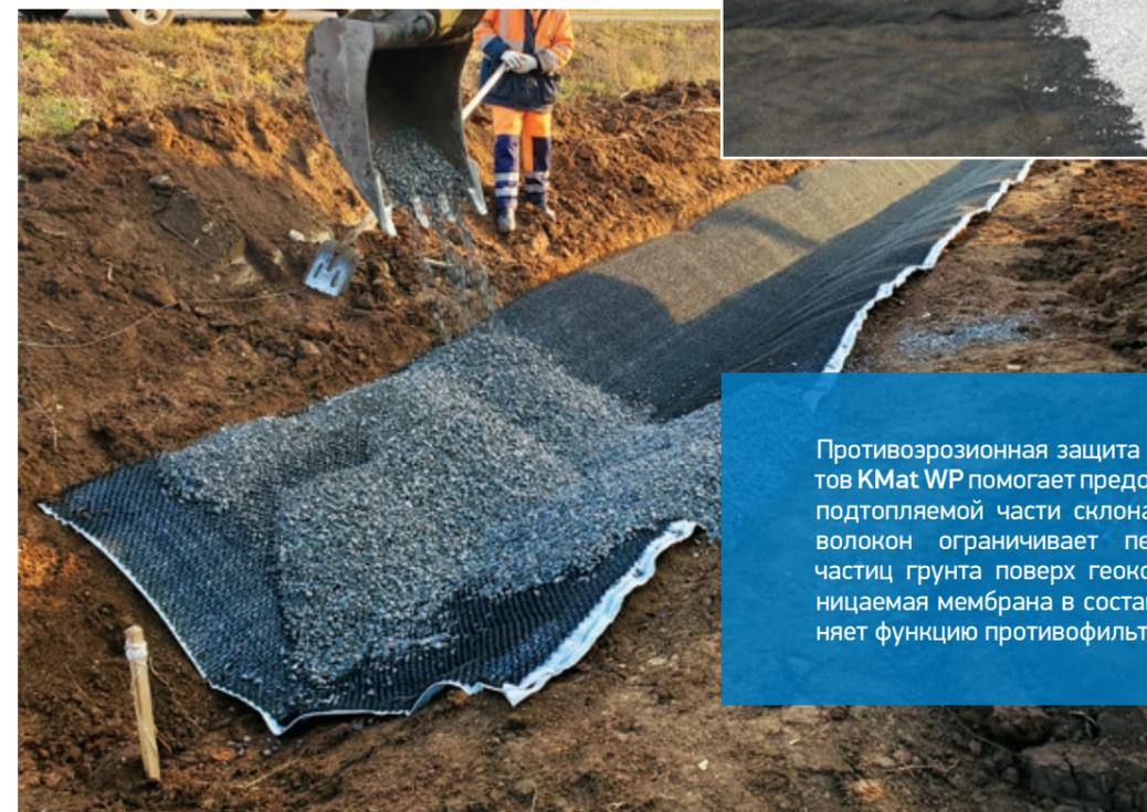
Противоэрозионная защита с помощью геокомпозитов KMat WP помогает предотвратить размыв грунта подтопляемой части склона. Хаотичная структура волокон ограничивает перемещения каменных частиц грунта поверх геокомпозита, а водонепроницаемая мембрана в составе геокомпозита выполняет функцию противодиффузионного экрана.
