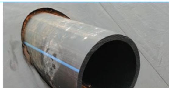
**2** Подготовка дополнительного изоляционного ковра из мембраны COVER UP исходя из размеров выступающей части трубы. Внутренний диаметр дополнительного ковра должен быть меньше диаметра трубы на 2 см. Для того чтобы надеть дополнительный ковер на трубу, необходимо размягчить и растянуть мембрану в месте технологического отверстия строительным феном.
