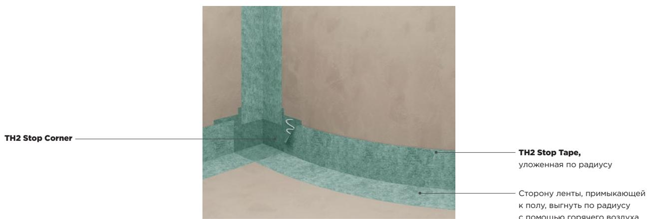
**Сформировать угол 90 гр. из ленты TH2 Stop Tape** перегнув ее вдоль пополам и уложить в горизонтальные стыки между полом и стеной и вертикальные стыки между стен на плиточный клей способом описанным выше. В местах захода ленты на угловые элементы выполнить соединение с помощью клея **T-MS**. **Нахлест ленты должен составлять 5 см.** Приклейте ленту **TH2 Stop Tape**, соединяя ее с угловыми элементами, по всему периметру помещения.
