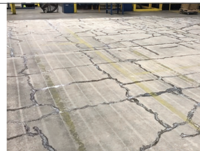
Деформация пола, растрескивание и расслоение бетонного монолита
