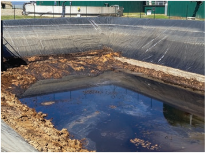
Навозохранилище, выполненное по такой технологии, уже сразу после монтажа готово к использованию.
