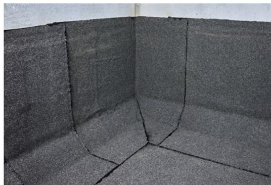
Высота заведения второго слоя кровли из Safety Flex Ceramic Grey EBP должна составлять не менее 350 мм (или на 100 мм выше первого слоя кровли).
