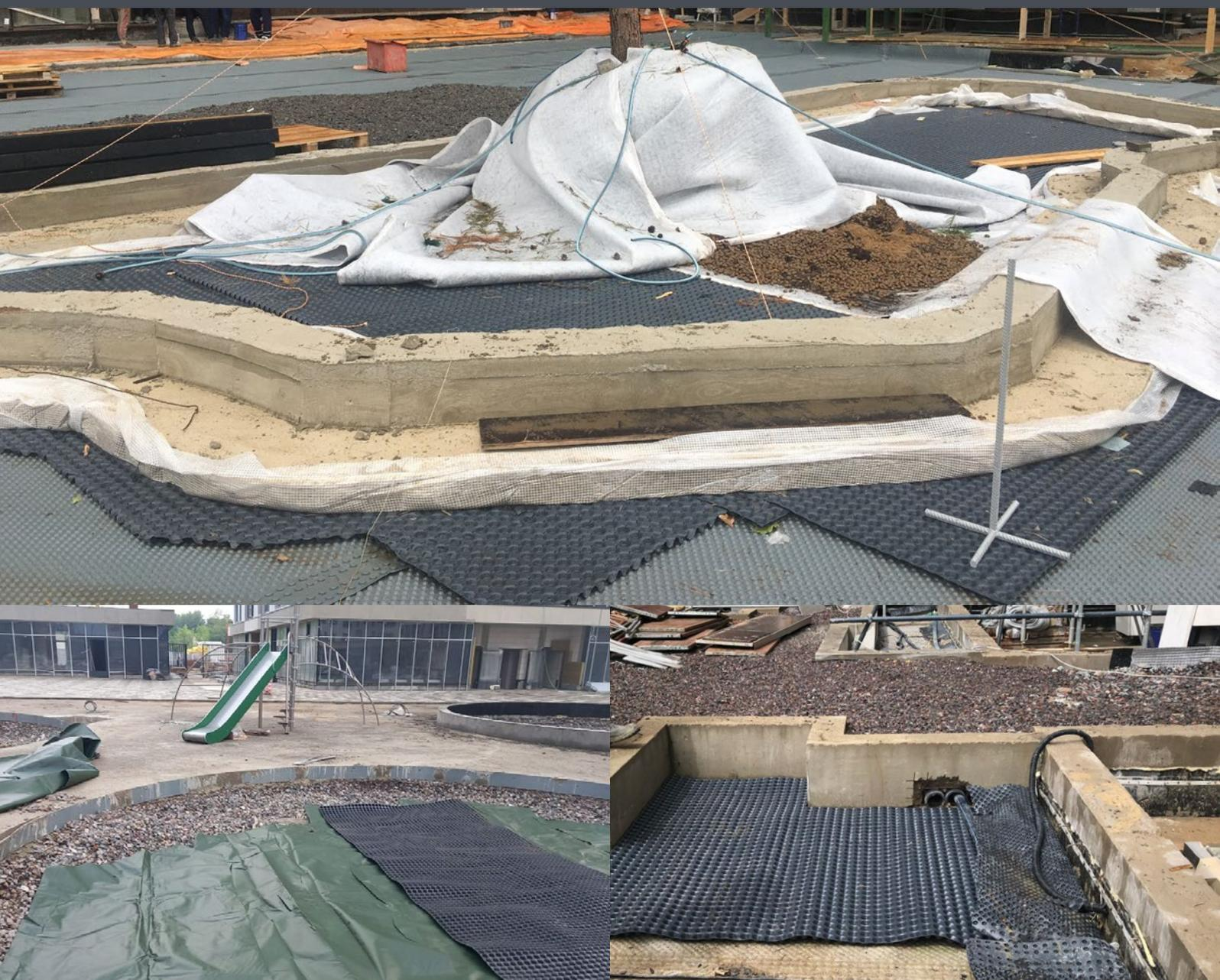
При помощи мембран Tefond, TMD и Maxistud F можно выполнять непрерывный пластовый дренаж по всей площади крыши, не зависимо от типов финишных покрытий.
