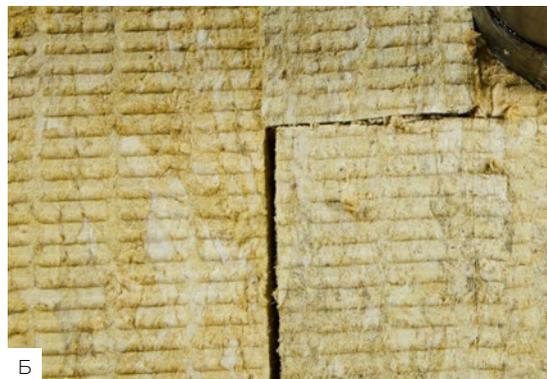
Плиты укладывайте плотно друг к другу. Недопустимо наличие внутри теплоизоляционного слоя пустот и зазоров более 2 мм. Такие зазоры необходимо заполнить материалом теплоизоляционного слоя.
