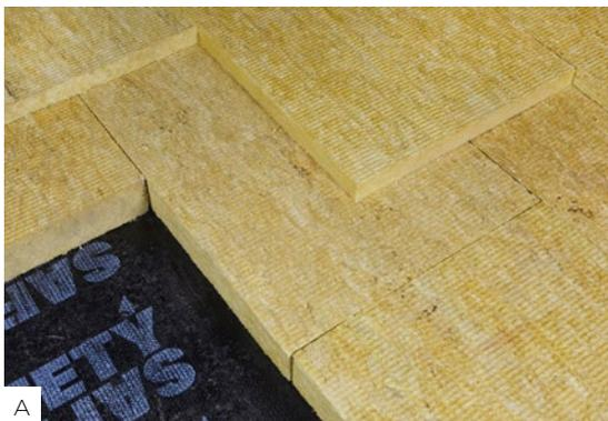
При устройстве теплоизоляции из двух и более слоев швы между плитами располагайте «вразбежку» со смещением не менее 150 мм в любом направлении.
