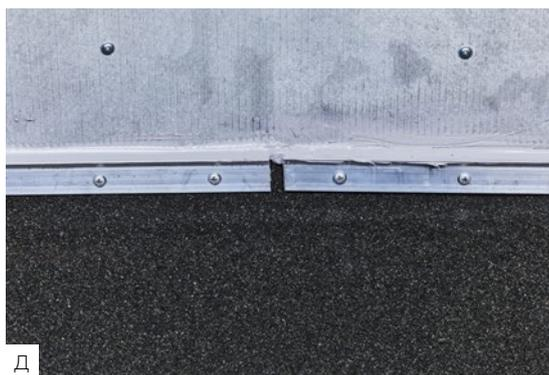
Заполните отгиб краевой рейки герметиком Битустик или полиуретановым герметиком.
