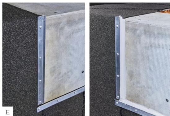
При наличии вертикальных переходов кровли закрепите вертикальный край краевой рейкой и нанесите герметик с двух сторон вертикальной рейки.
