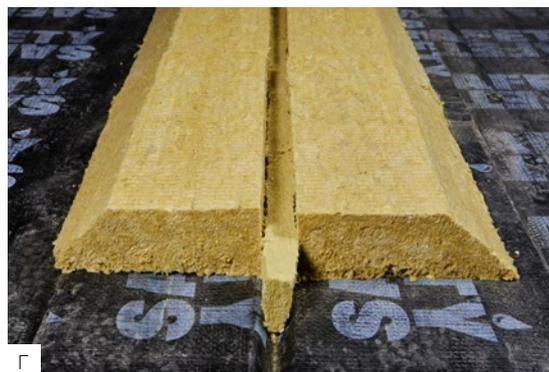
Приклейте минеральную вату, разогревая поверхность кровли пламенем горелки с каждой стороны шва.
