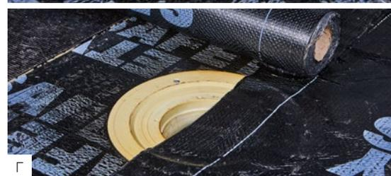
При использовании воронки с обжимным фланцем наплавьте пароизоляцию на воронку.
