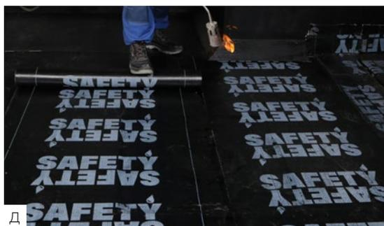
Д Продольный нахлест смежных полотен должен составлять 80–100 мм.
