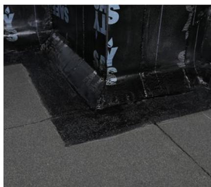
Для качественного наплавления втопите крупнозернистую посыпку в битумно-полимерное вяжущее на всю ширину будущего нахлеста (200 мм).
