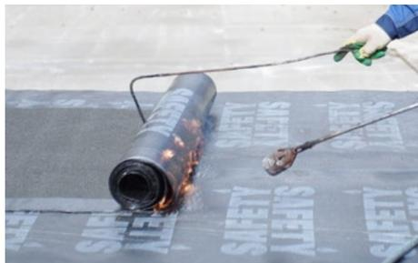
**Крюк для раскатывания рулонов** — приспособление для раскатывания рулонов битумно-полимерных материалов при наплавлении.
