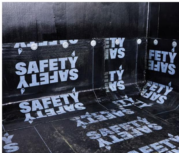
При оклейке парапета высотой более 600 мм потребуется дополнительное крепление кровельного ковра.
