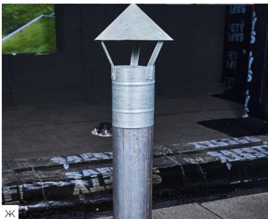
Завершите работу, установив на край трубы колпак из оцинкованной стали. Диаметр колпака должен быть больше диаметра трубы минимум на 60 мм.
