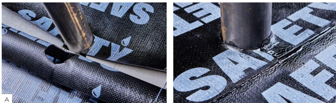
Наплавьте первый слой кровли из материала Safety EPP по всей площади крыши.
