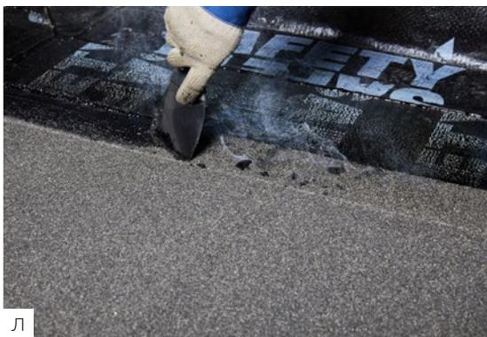
Перед наплавлением по крупнозернистой посыпке (торцевые нахлесты, примыкания к вертикальным конструкциям и т.п.) удалите посыпку из области наплавления:
