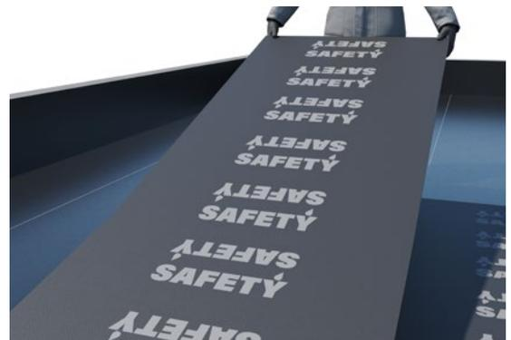
Выровняйте полотно Safety EPP в соответствии с нанесенной разметкой. Для этого один кровельщик должен встать на край рулона, а второй выравнивать и натягивать полотно с другого края. На выставленном и выровненном полотне не должно быть волн.
