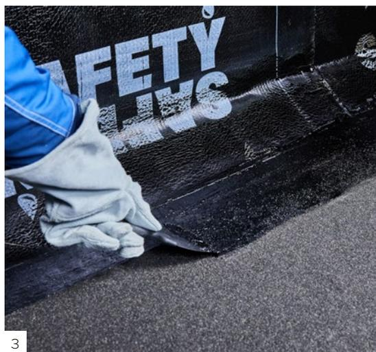
Наплавьте подготовленное полотно Safety Flex Ceramic Grey EBP в соответствии с п. 3.3.
