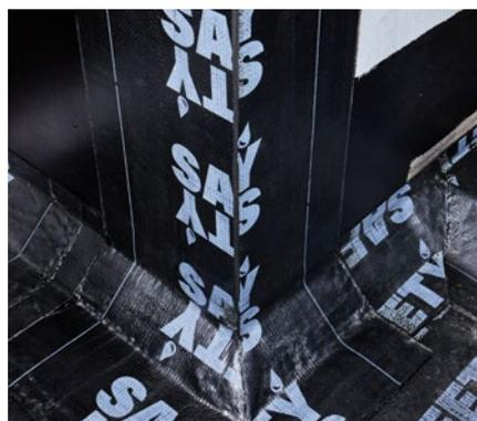
Наплавьте Safety EPP с другой стороны угла.
