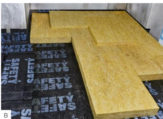
Плиты укладывайте в направлении «на себя». Это уменьшит повреждение (вытапываемость) плит во время монтажа.
