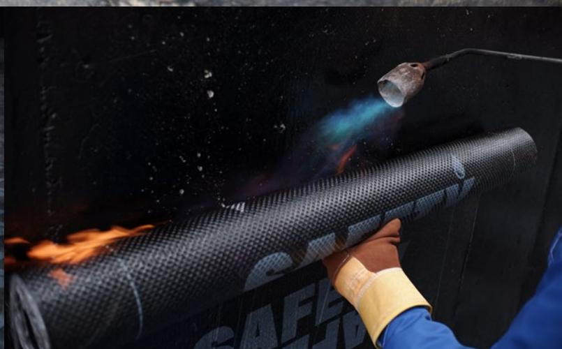
При наплавлении используйте стандартную горелку.
