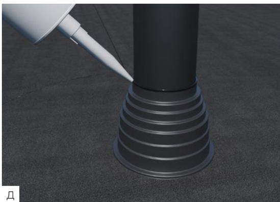
Для герметизации соединения трубы и переходника используйте герметик Битустик или полиуретановый герметик.
