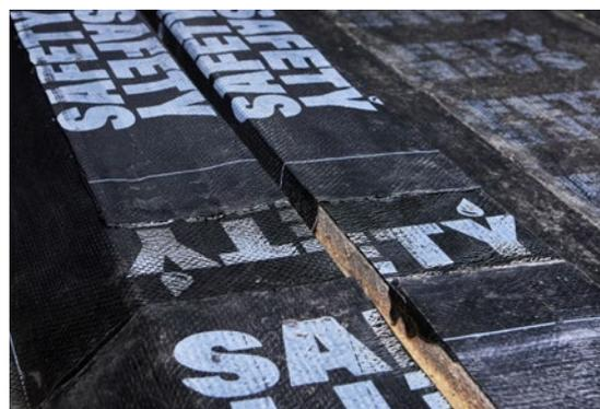
Накройте поверхность деформационного шва с обеих сторон слоем усиления из материала Safety EPP с разрывом по деформационному шву. Края полос слоя усиления сплавьте с нижним слоем ковра на величину не менее 100 мм.
