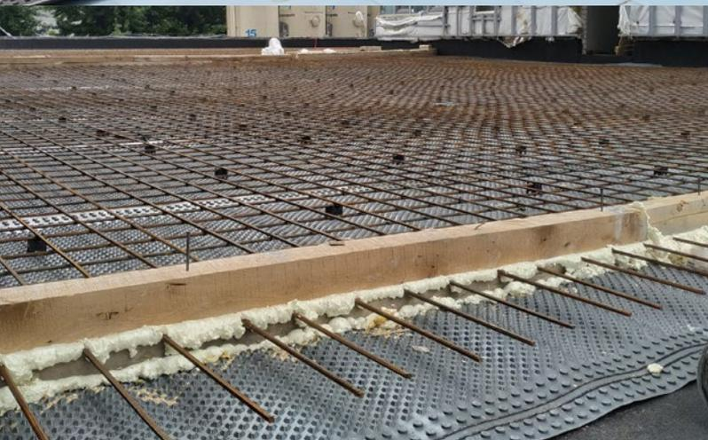
**Важно!** Укладку материала производите при температуре от  $-15\text{ }^{\circ}\text{C}$  до  $+40\text{ }^{\circ}\text{C}$ . При температуре ниже  $+5\text{ }^{\circ}\text{C}$  для прогрева шовного герметика и герметизирующих лент используйте строительный фен или тепловую пушку. Использование открытого пламени для прогрева материала категорически запрещено!
