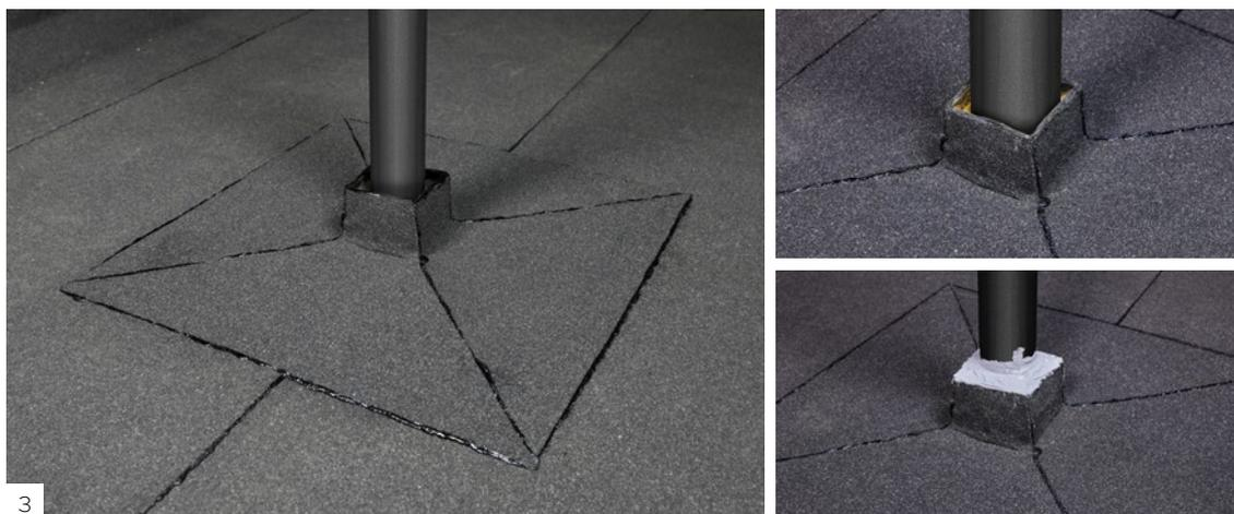
Заполните стакан монтажной пеной и нанесите сверху полиуретановый герметик. Глубина заполнения герметиком должна составлять 20–30 мм.
