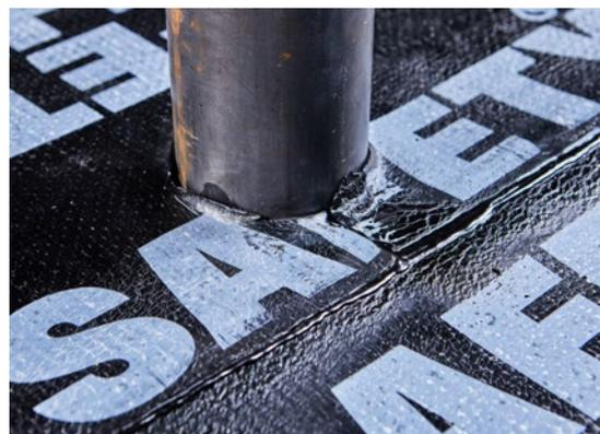
Наплавьте первый оклад и накладку усиления на трубу. Лепестки оклада должны быть смещены относительно лепестков накладки.
