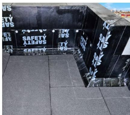
Наплавьте второй слой кровли из Safety Flex Ceramic Grey EBP на горизонтальную поверхность по всей площади.
