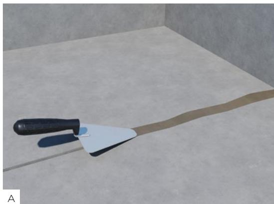
Заделайте неровности и стыки несущих железобетонных плит цементно-песчаным раствором марки не ниже М150.
