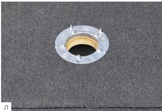
Установите прижимной фланец и затяните при помощи гаек.
