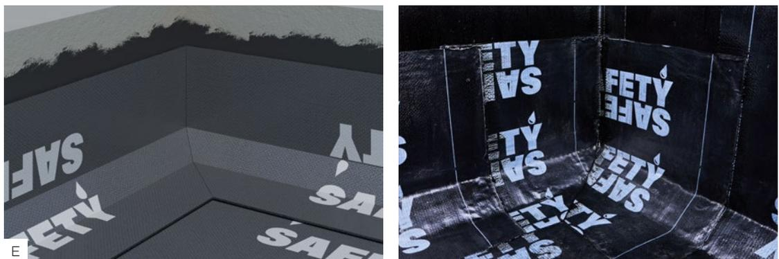
Наплавьте первый слой кровли из Safety EPP на вертикальную поверхность с другой стороны угла.
