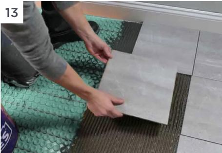
Далее можно переходить к облицовке. Для этого поверх мембраны наносится плиточный клей так, чтобы заполнились все пустоты, выполняются бороздки зубчатым шпателем и по желаемой схеме укладывается плитка либо керамогранит.
