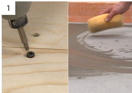
1 Перед укладкой полотна No Crack Heat основание необходимо подготовить – очистить от мусора и обеспылить, закрутить торчащие саморезы, если таковые присутствуют. При наличии горизонтальных трещин шире 3,5 мм, такие трещины необходимо заделать. После этого основание увлажняют губкой, смоченной в чистой воде.
