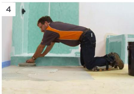
4 Подготовленный клей наносится зубчатым шпателем (6 x 6 мм) на площадь, равную одному листу полотна.
