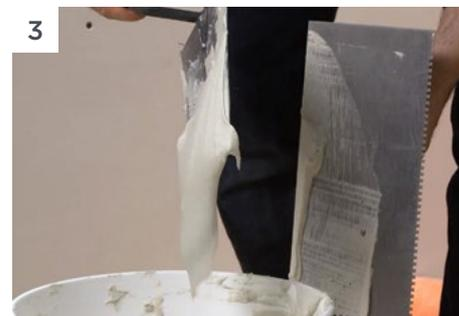
3 Плиточный клей класса не ниже С2 разводится водой на 10-15% больше, чем рекомендовано производителем.
