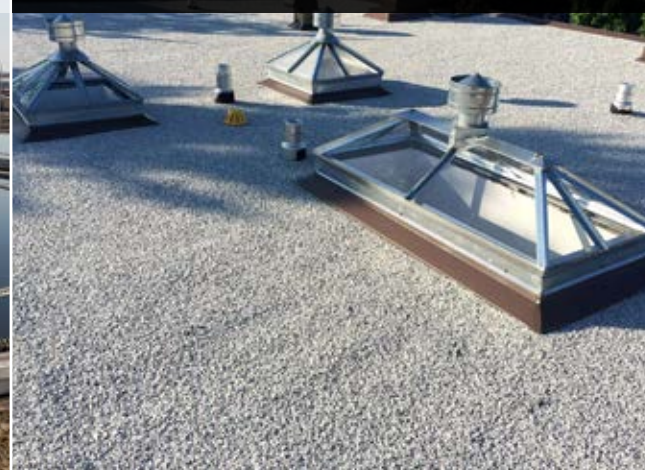
Устройство неэксплуатируемой кровли
