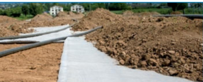
Устройство пластового дренажа с применением геокompозита QDrain начинается с подготовки основания, особое внимание следует уделять соблюдению уклона и уплотнению основания. Далее укладываются рулоны дренажного геокompозита.
