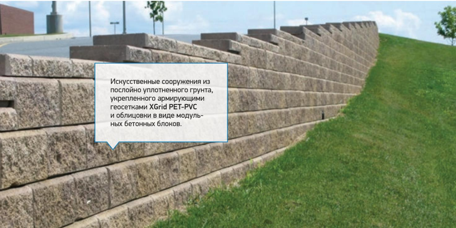
Искусственные сооружения из послойно уплотненного грунта, укрепленного армирующими геосетками XGrid PET-PVC и облицовки в виде модульных бетонных блоков.
