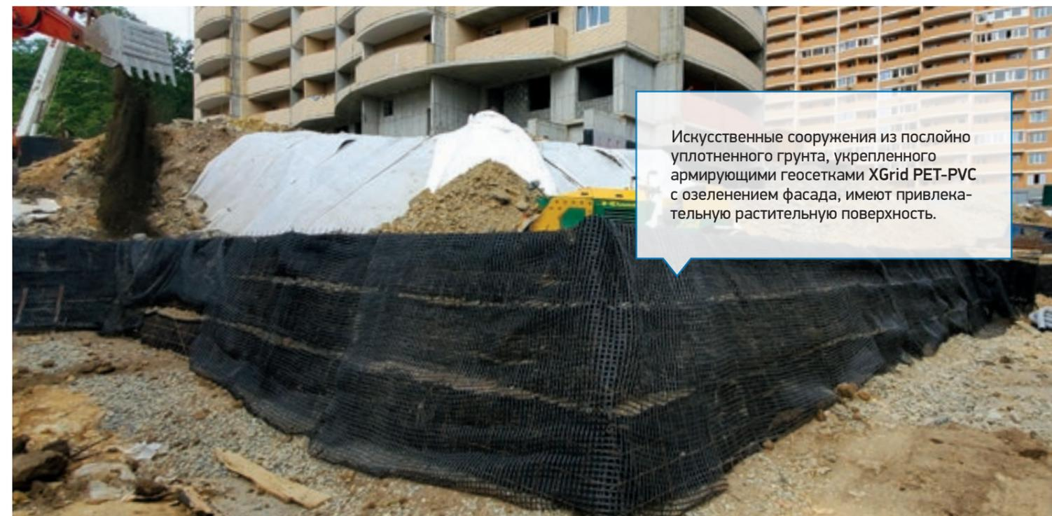
Искусственные сооружения из послойно уплотненного грунта, укрепленного армирующими геосетками XGrid PET-PVC с озеленением фасада, имеют привлекательную растительную поверхность.
