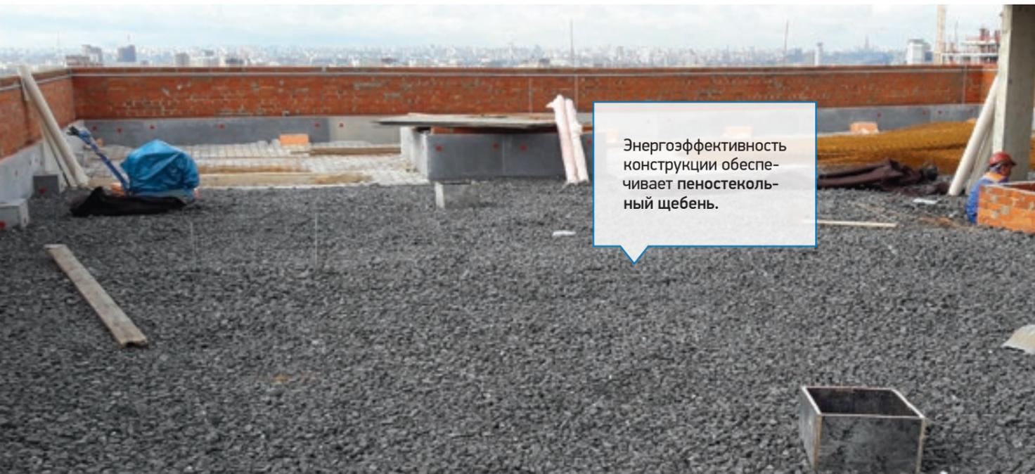
Энергоэффективность конструкции обеспечивает пеностекольный щебень.
