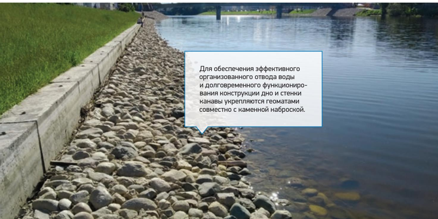
Для обеспечения эффективного организованного отвода воды и долговременного функционирования конструкции дно и стенки канавы укрепляются геоматами совместно с каменной наброской.
