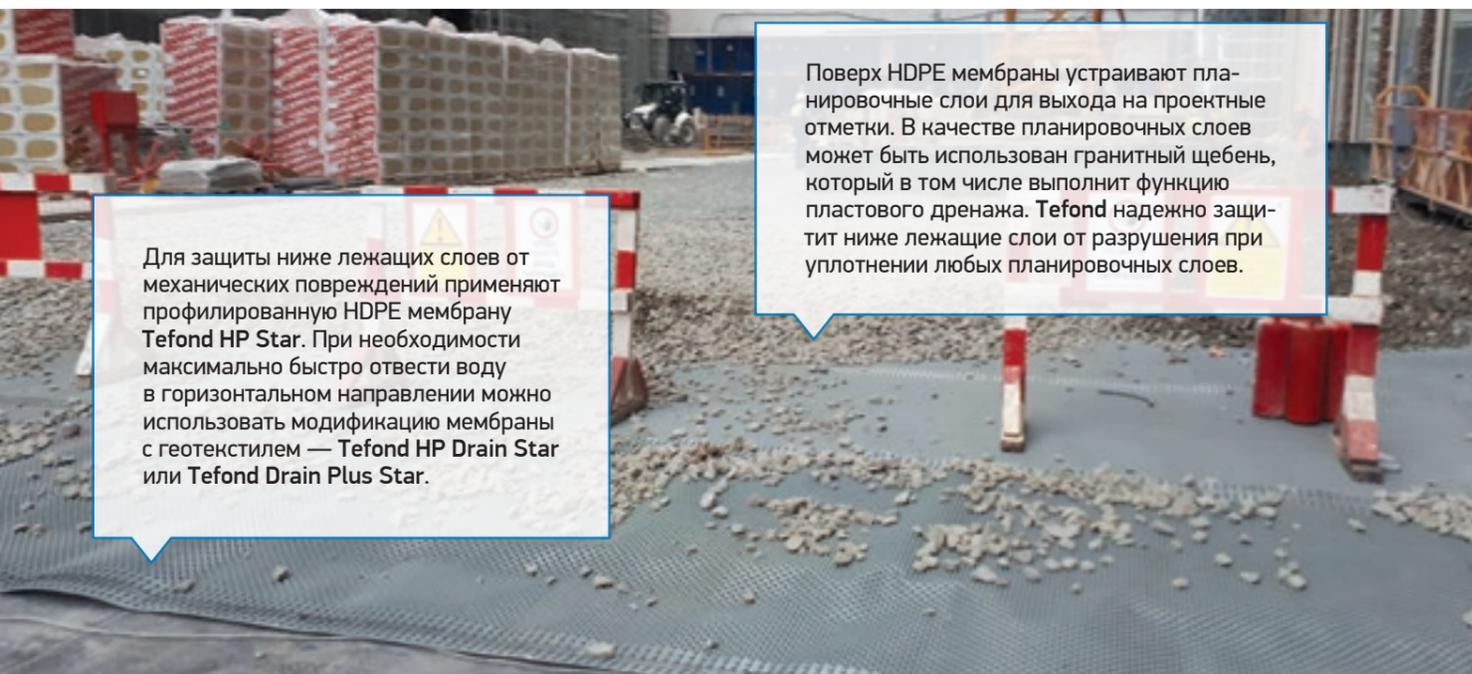
Для защиты ниже лежащих слоев от механических повреждений применяют профилированную HDPE мембрану **Tefond HP Star**. При необходимости максимально быстро отвести воду в горизонтальном направлении можно использовать модификацию мембраны с геотекстилем — **Tefond HP Drain Star** или **Tefond Drain Plus Star**.
