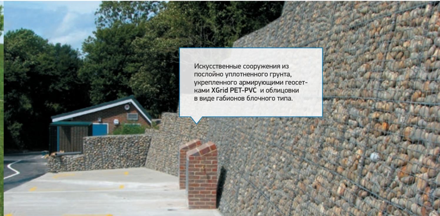
Искусственные сооружения из послойно уплотненного грунта, укрепленного армирующими геосетками XGrid PET-PVC и облицовки в виде габионов блочного типа.
