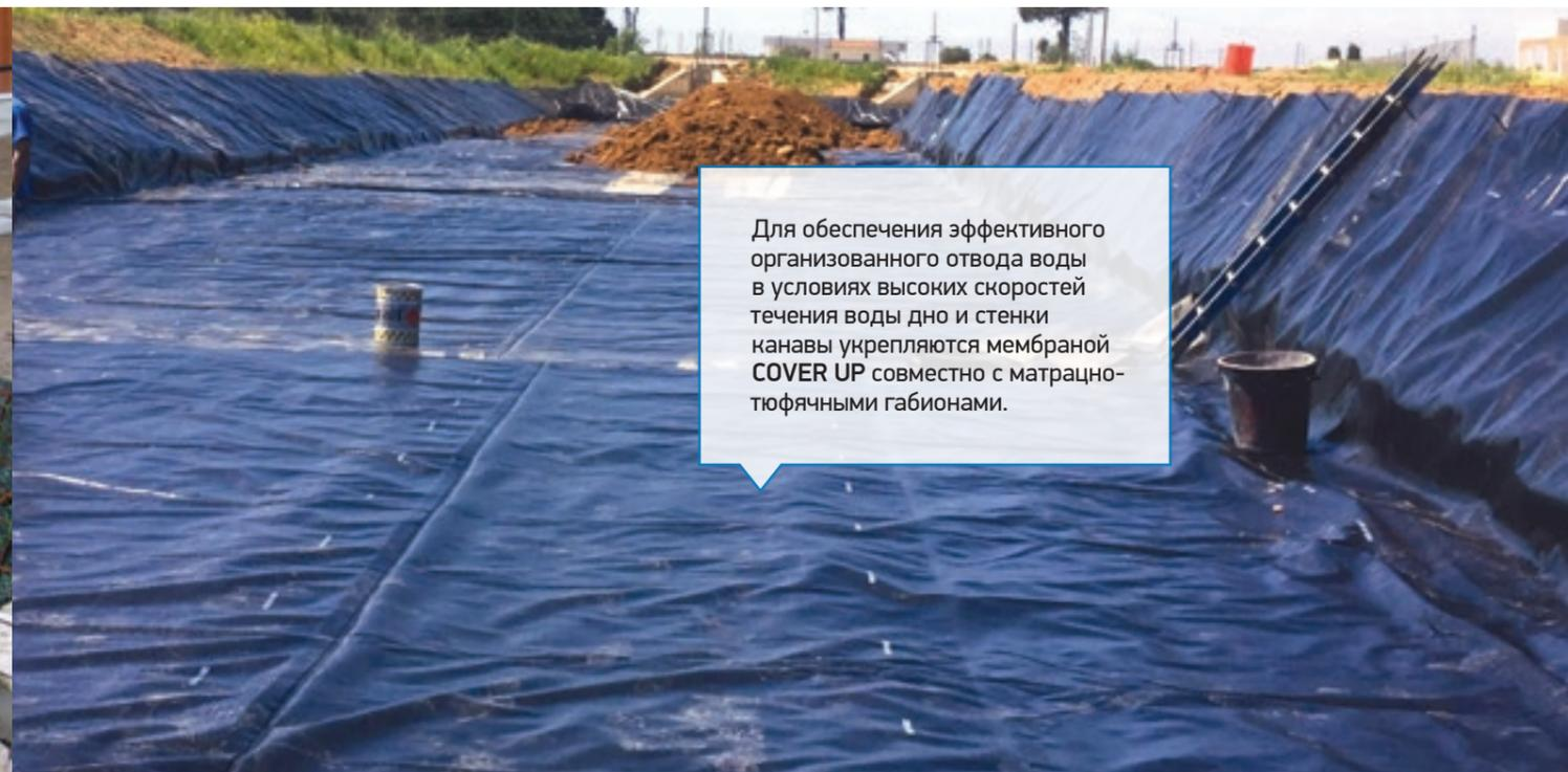
Для обеспечения эффективного организованного отвода воды в условиях высоких скоростей течения воды дно и стенки канавы укрепляются мембраной COVER UP совместно с матрацно-тюфячными габионами.
