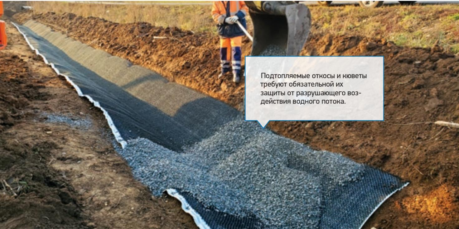
Подтопляемые откосы и кюветы требуют обязательной их защиты от разрушающего воздействия водного потока.
