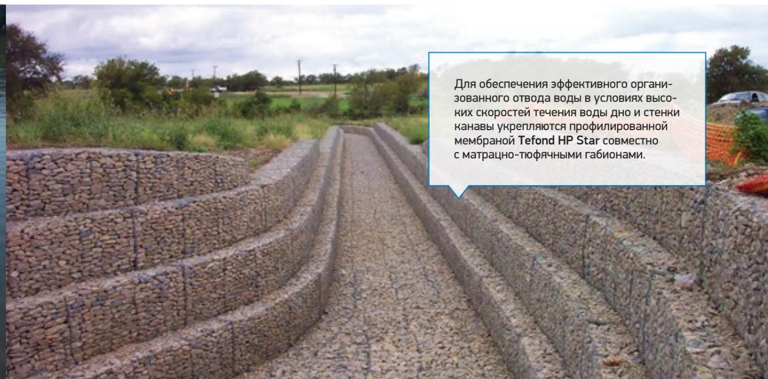
Для обеспечения эффективного организованного отвода воды в условиях высоких скоростей течения воды дно и стенки канавы укрепляются профилированной мембраной Tefond HP Star совместно с матрацно-тюфячными габионами.
