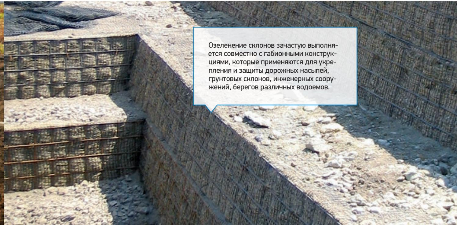
Озеленение склонов зачастую выполняется совместно с габионными конструкциями, которые применяются для укрепления и защиты дорожных насыпей, грунтовых склонов, инженерных сооружений, берегов различных водоемов.
