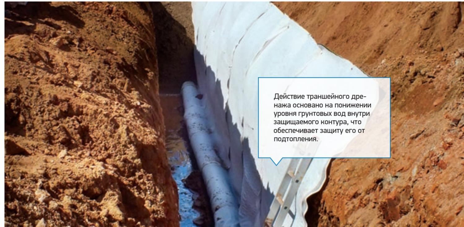
Действие траншейного дренажа основано на понижении уровня грунтовых вод внутри защищаемого контура, что обеспечивает защиту его от подтопления.
