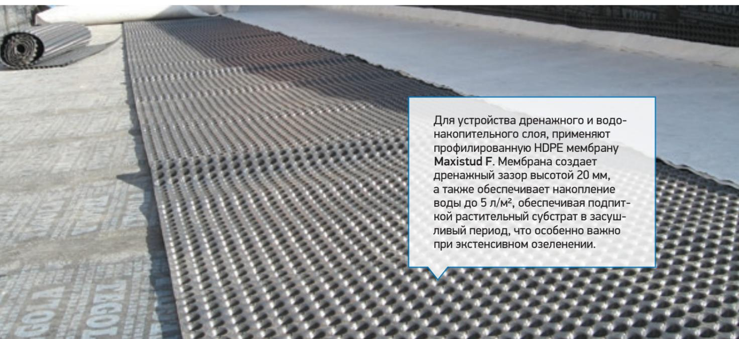
Для устройства дренажного и водонакопительного слоя, применяют профилированную HDPE мембрану Maxistud F. Мембрана создает дренажный зазор высотой 20 мм, а также обеспечивает накопление воды до 5 л/м², обеспечивая подпиткой растительный субстрат в засушливый период, что особенно важно при экстенсивном озеленении.
