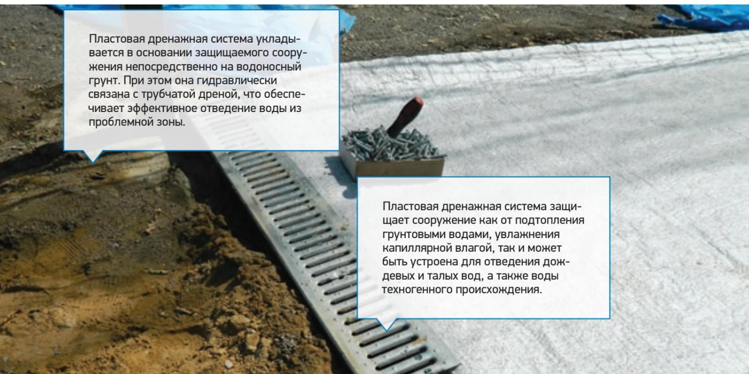
Пластовая дренажная система укладывается в основании защищаемого сооружения непосредственно на водоносный грунт. При этом она гидравлически связана с трубчатой дренаем, что обеспечивает эффективное отведение воды из проблемной зоны.
