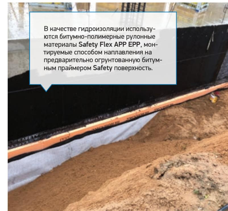
В качестве гидроизоляции используются битумно-полимерные рулонные материалы Safety Flex APP EPP, монтируемые способом наплавления на предварительно огрунтованную битумным праймером Safety поверхность.
