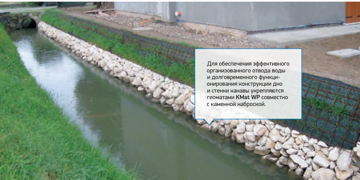
Для обеспечения эффективного организованного отвода воды и долговременного функционирования конструкции дно и стенки канавы укрепляются геоматами KMat WP совместно с каменной наброской.
