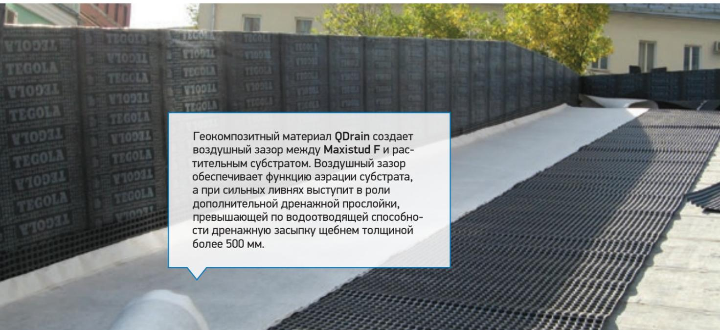
Геокомпозитный материал QDrain создает воздушный зазор между Maxistud F и растительным субстратом. Воздушный зазор обеспечивает функцию аэрации субстрата, а при сильных ливнях выступит в роли дополнительной дренажной прослойки, превышающей по водоотводящей способности дренажную засыпку щебнем толщиной более 500 мм.
