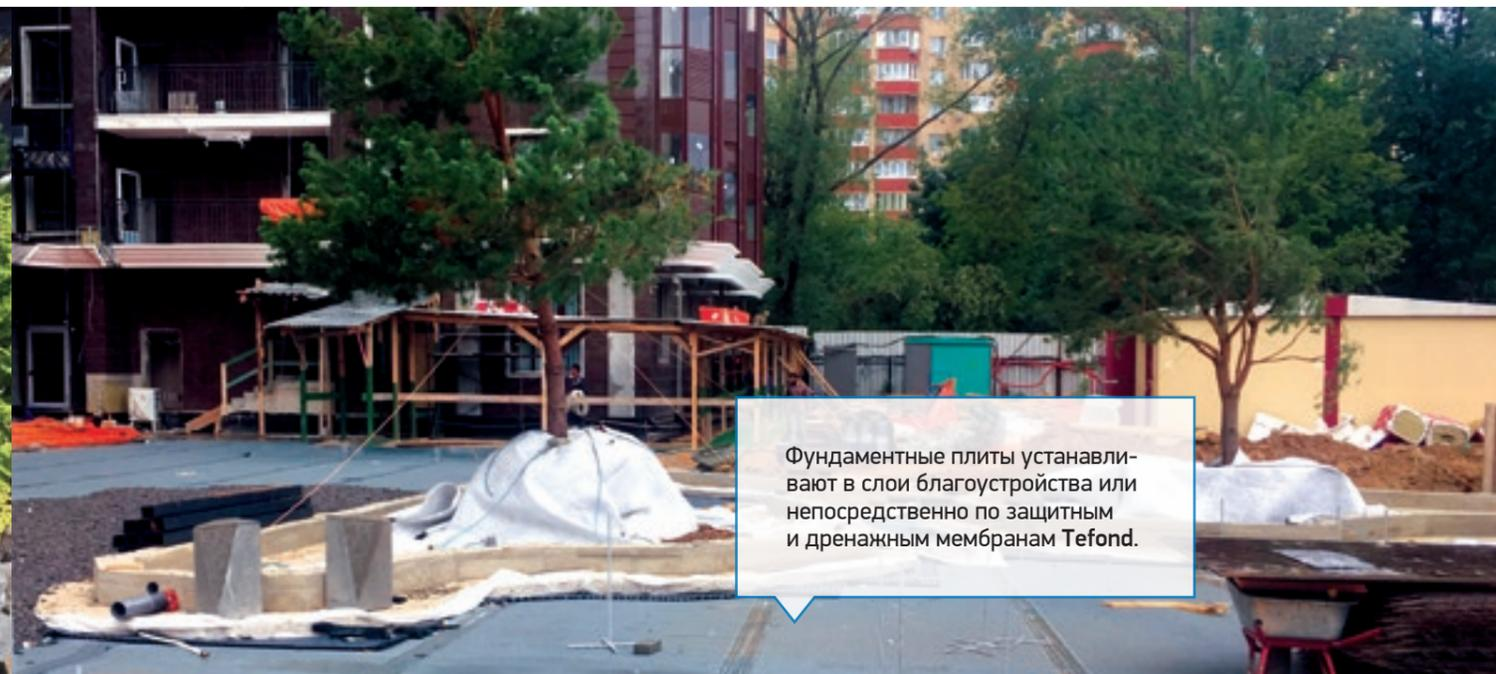
Фундаментные плиты устанавливают в слои благоустройства или непосредственно по защитным и дренажным мембранам Tefond.
