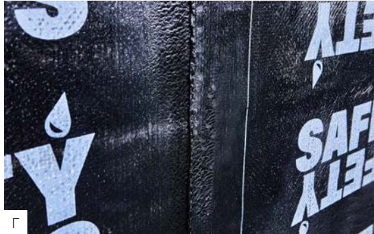
Соблюдайте нахлест смежных полотен на вертикали 80–100 мм.
