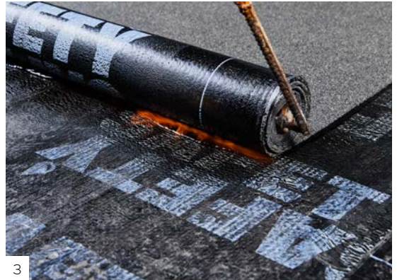
Наплавьте верхний слой Safety с крупнозернистой посыпкой в соответствии с п. 4.2.2.
