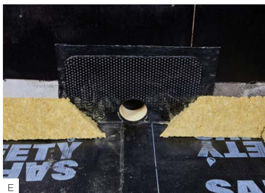
Е Установите переходной бортик из минеральной ваты с прочностью на сжатие при 10 % деформации не менее 60 кПа в соответствии с п. 4.1.1.
