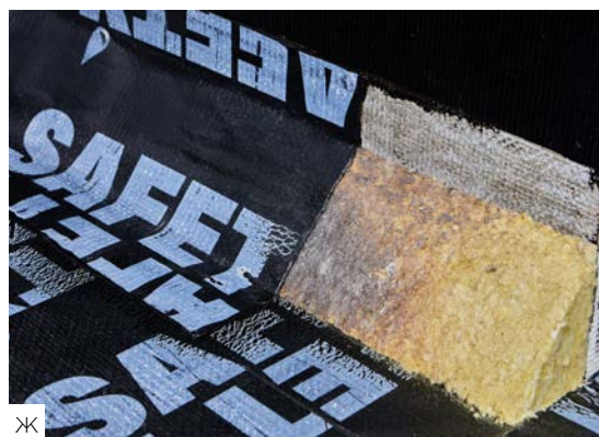
Ж Наплавьте полосы усиления на переходной бортик в соответствии с п. 4.1.1.
