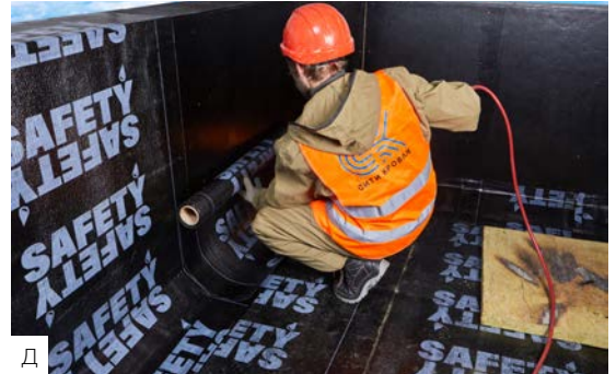
Наплавьте подготовленное полотно Safety EPP в соответствии с п. 3.3.
