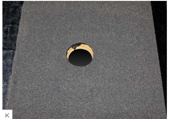
Прорежьте в кровельном материале водосточное отверстие. По срезу кровли убедитесь в качестве выполненных работ.
