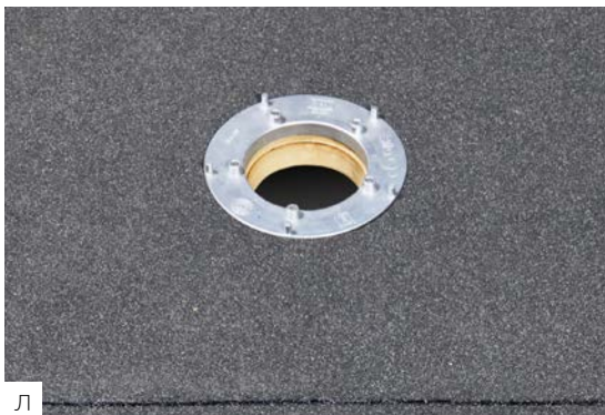
Установите прижимной фланец и затяните при помощи гаек. Для герметизации фланцевого соединения с кровельным ковром рекомендуется сначала нанести на нижнюю сторону фланца битумный герметик Битустик.
