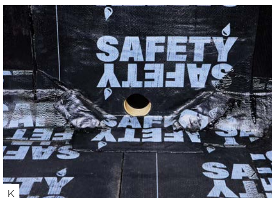
К Прорежьте в первом слое кровли водосливное отверстие.
