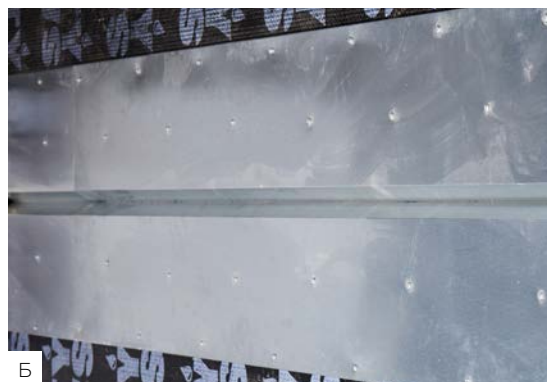
Б Закрепите в деформационном шве компенсатор из оцинкованной стали. Компенсатор будет поддерживать пароизоляцию в шве.
